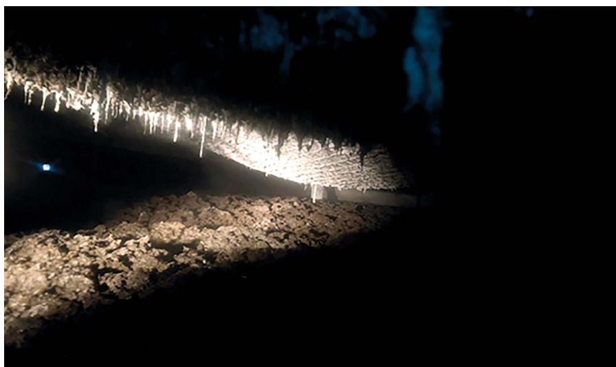
Obr. 1: Příčinou tvorby krust bývá příliš nízká viskozita digestátu
